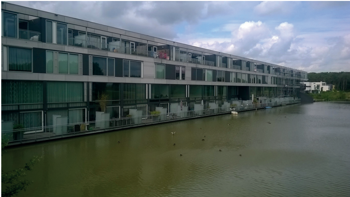
FIGUUR 6.5 WONEN AAN HET WATER. DOOR TE LAAG BOUWPEIL IS DE BERGING IN DE WATERPARTIJ FORS AFGENOMEN
