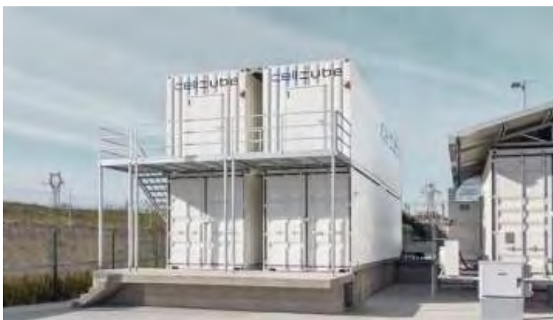
VOORBEELDOPSTELLING VAN EEN REDOX FLOW BATTERIJ
