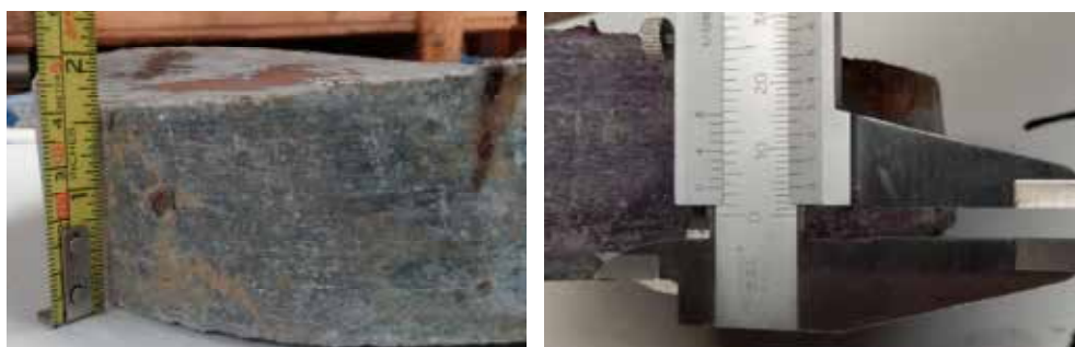
Figuur 5.9 Voorbeeld boorkernonderzoek. Links: wanddiktemeting. Rechts: Meting uitloging (4,3 mm). Uit: Striper, P en Dijkstra. R. (2014). Hoogheemraadschap Hollands Noorderkwartier. Bevindingen initiële AC-inspectie.
