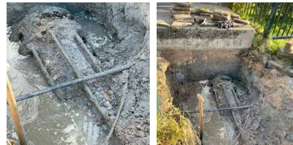
Figuur 5.10 Proefsleuf met pendelstuk
