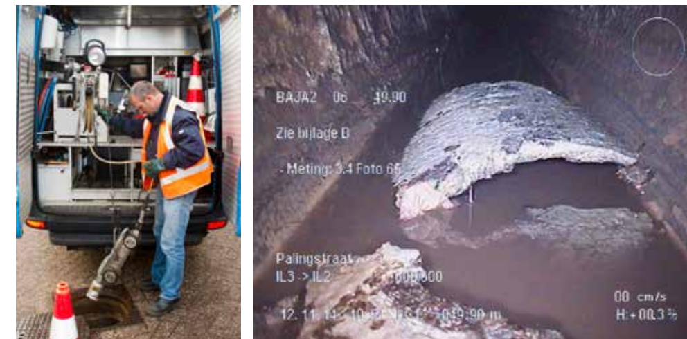
Figuur 5.1 Links: Inbrengen inspectiecamera (Foto afkomstig uit RIONED-beeldenbank). Rechts: Losgeraakte scaling in persleiding (Foto: Waterschap Brabantse Delta)
