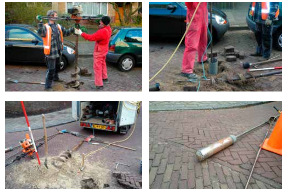
Figuur 5.7 Nemen van boorkern. Foto's N. Stanic (2013).
