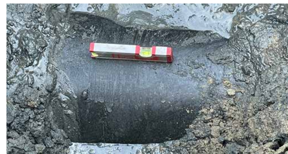
Figuur 5.11 Inmeten zakking leiding naast gemaal
