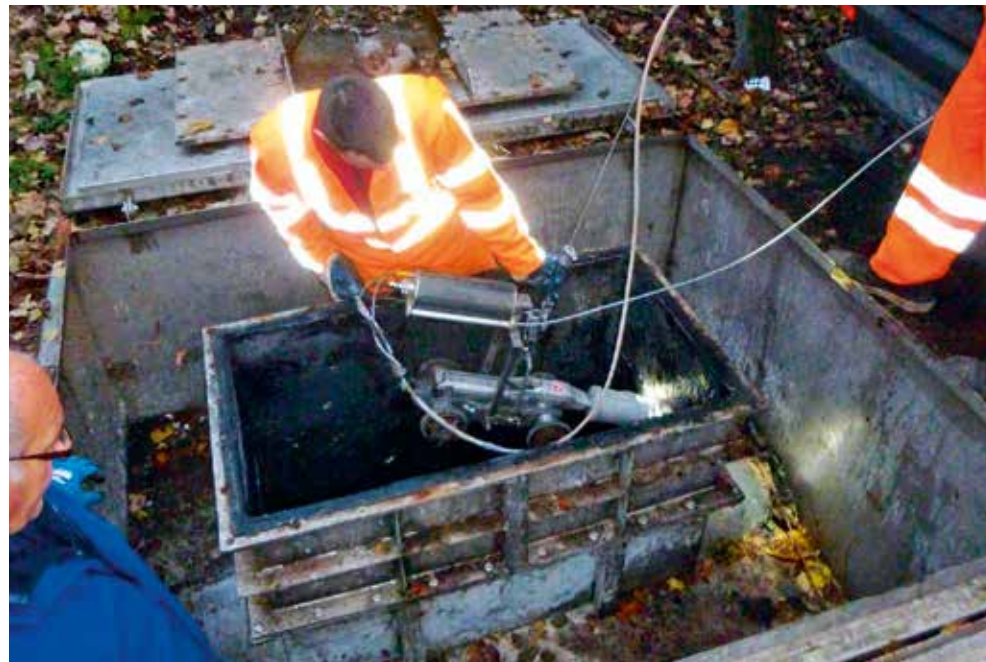
Figuur 5.3 Inbrengen inspectieapparatuur. Foto Waterschap Brabantse Delta.
